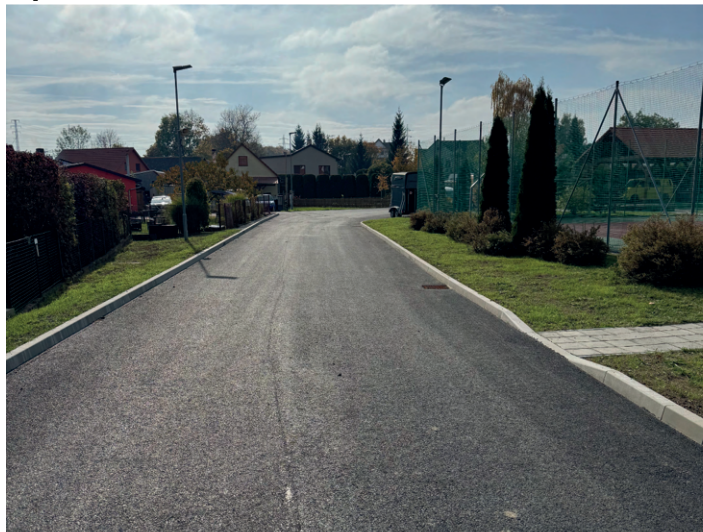
Oprava komunikace Pod Návsí
